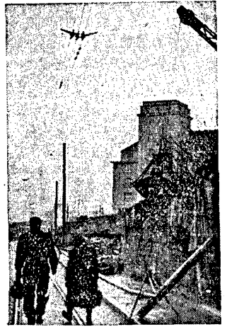
Aufnahmen: Günter Oberst. Unter den Zähnen des Baggers verschwindet die Saacke'sche Mauer in der Bahnhofstraße.
